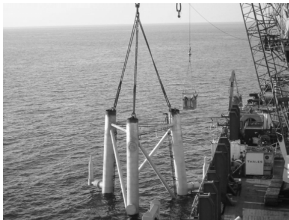
شکل ۲-۱ شمای کلی قرارگیری یک نمونه جاکت سه پایه روی بستر دریا
