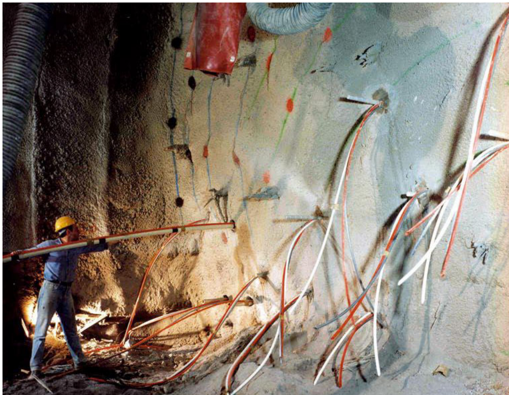
شکل ۱-۳: نصب المان‌های الیاف شیشه در داخل سینه‌کار با تزریق دوغاب (دستی) [۱]
